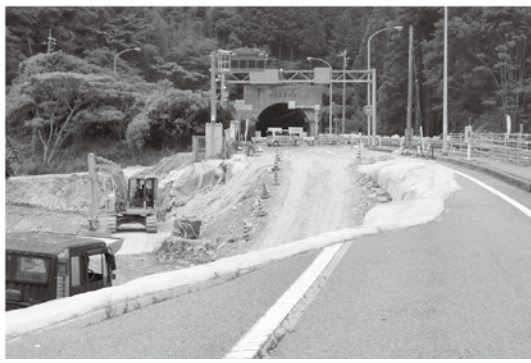
国道191号(須佐トンネル出口、6月下旬)
