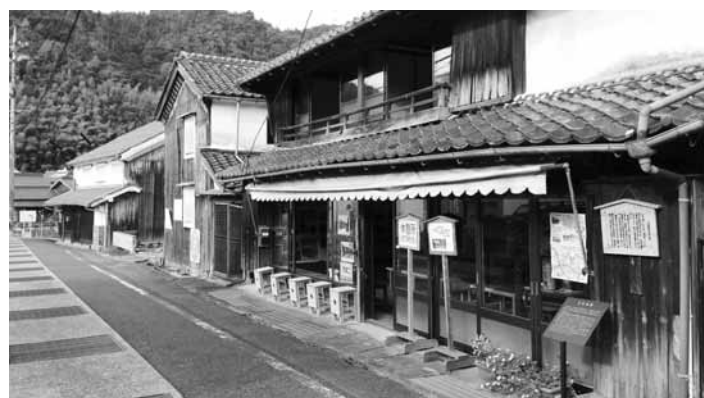
家の前に、竹筒の一輪挿しや、その家の歴史を紹介した看板を設置
