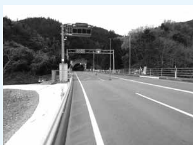
復旧工事が完了し、交通規制が解除された国道191号(須佐トンネル付近)上は災害直後、下は工事完了後(平成26年12月)
