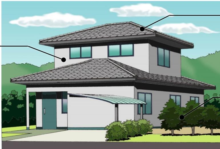
ねずみ色のスレート和瓦葺きで寄棟による勾配屋根
