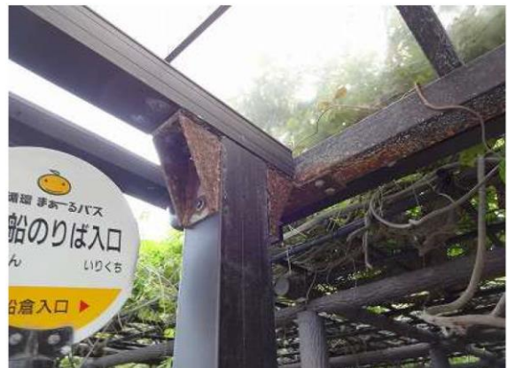
【上屋の劣化状況】
