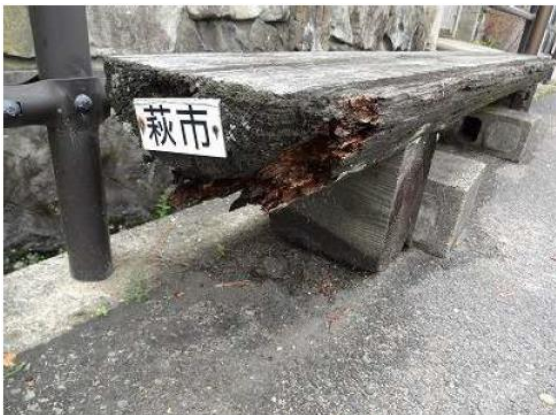
【ベンチの劣化状況】
