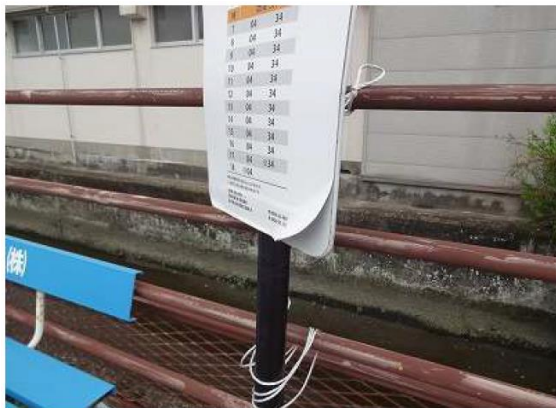
【バス停の劣化状況】
