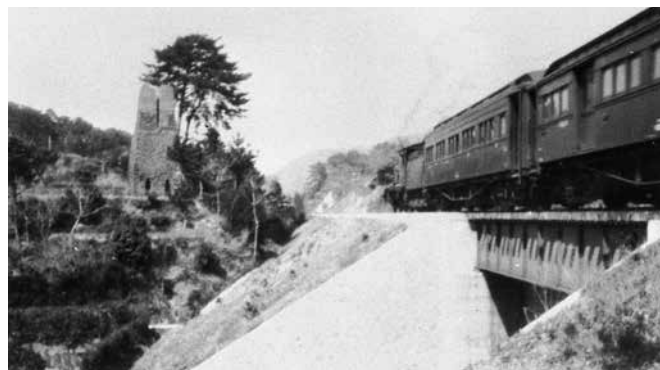
敷設間もない鉄道の上を走る列車 萩反射炉は大正13年(1924)に国の指定文化財に
