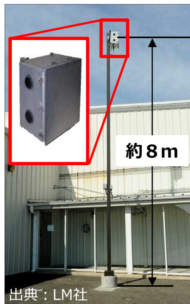
メインビームの照射を停止する機能のためのモニター用アンテナ（LM社工場で運用中）
