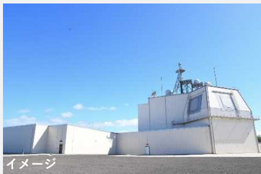
レーダー施設
