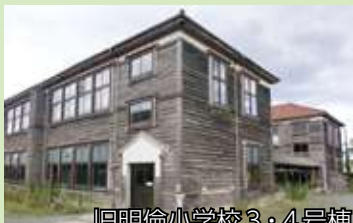
旧明倫小学校3・4号棟
