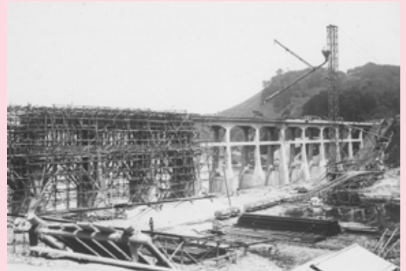
工事中の惣郷川橋梁
