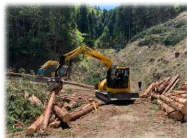
森林団地内の作業の様子
