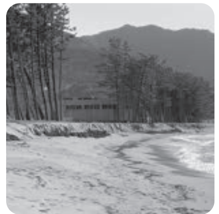
浸食が進む「西ノ浜」
