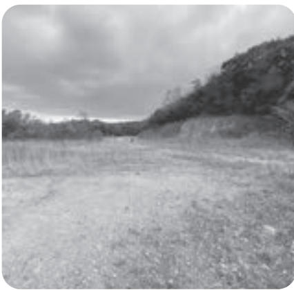
遠見団地造成地
