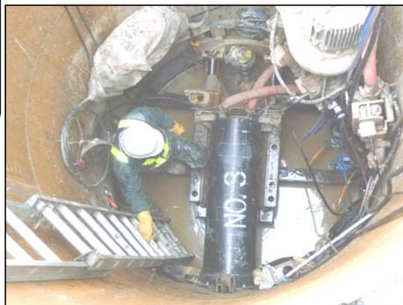
下水道工事（推進工法）の様子▲
