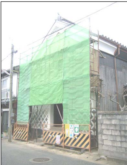
▲現在の整備状況 （旧小池家土蔵 外観）
