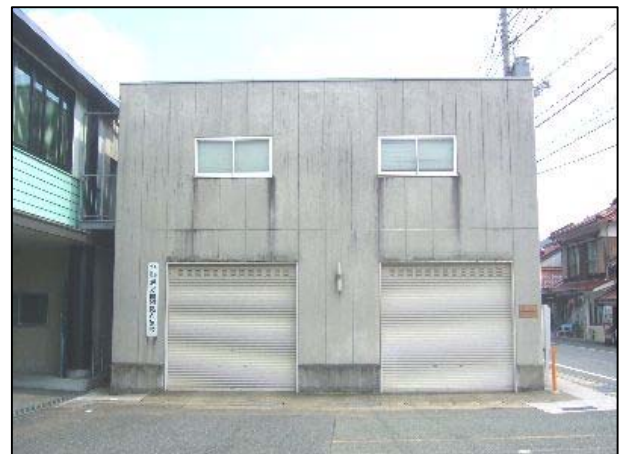
明木消防器庫▲
