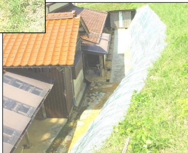
簡易な工法で復旧した住宅裏山▲
