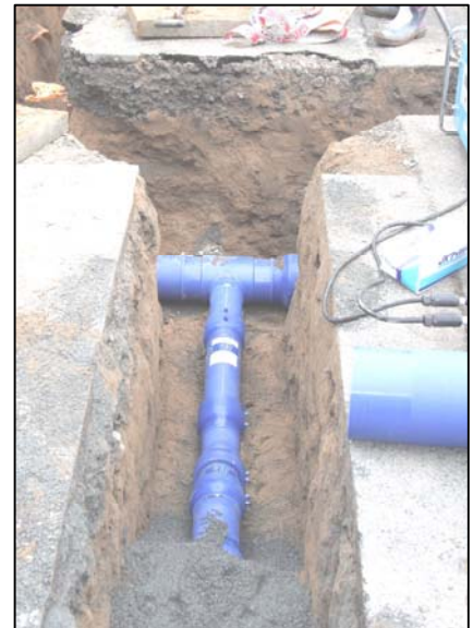
水道管布設替工事の様子 ▲
