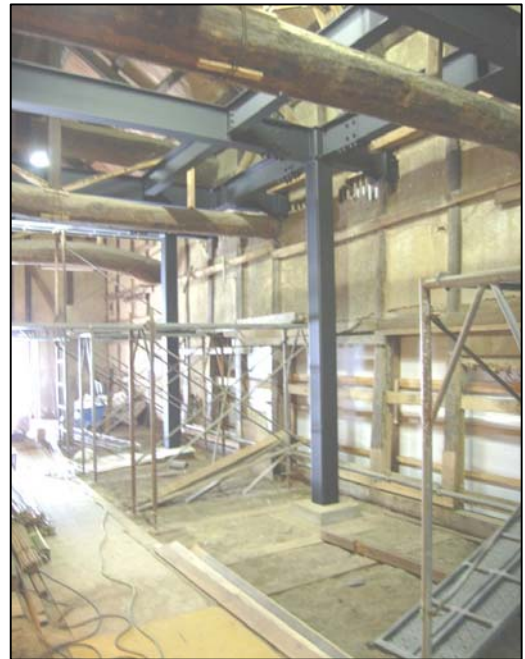
▲現在の整備状況▲ （旧小池家土蔵 内部）
