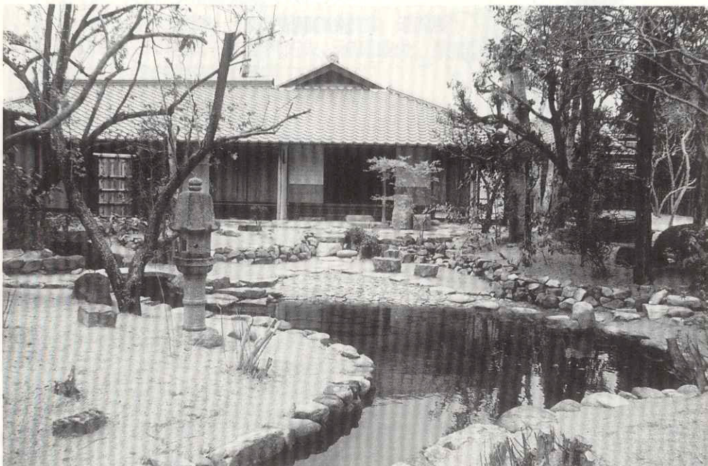
約3,600万円をかけて修復工事が完成した旧湯川家屋敷
