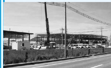
萩有料道路から工事現場を望む
