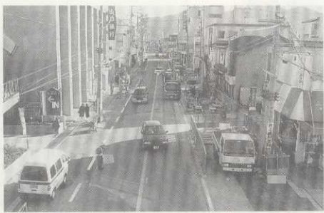
電線類地中化工事が進められる吉田通り
