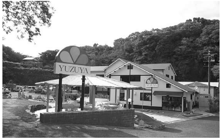
▲完成間近となった柚子屋本店の新社屋 (2002年8月20日撮影)
