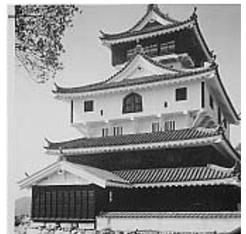
江戸時代初め築城わずか7年で取り壊され、昭和37年に再建された岩国城跡天守閣(『江戸時代人づくり風土記』より)
