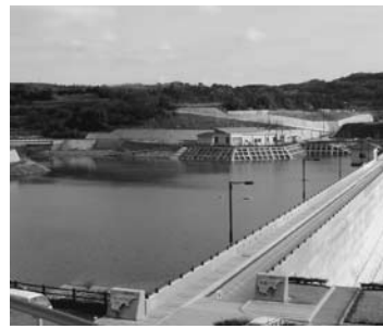
島民待望の見島ダム
