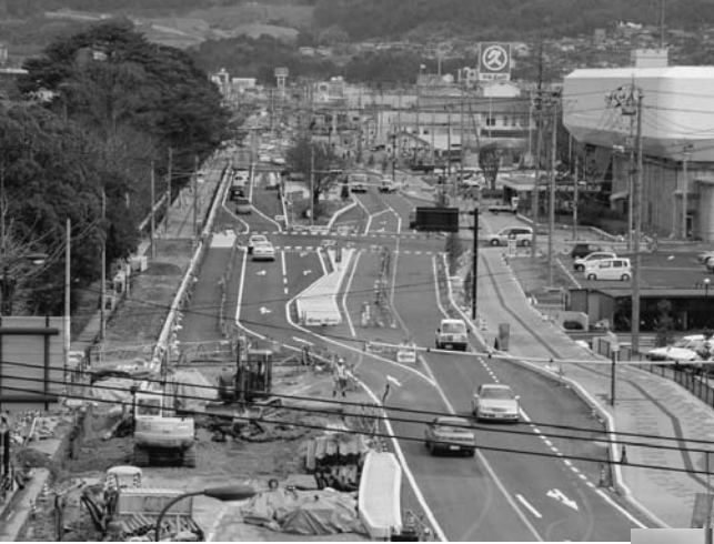
国道191号（市民館前）の4車線化工事
