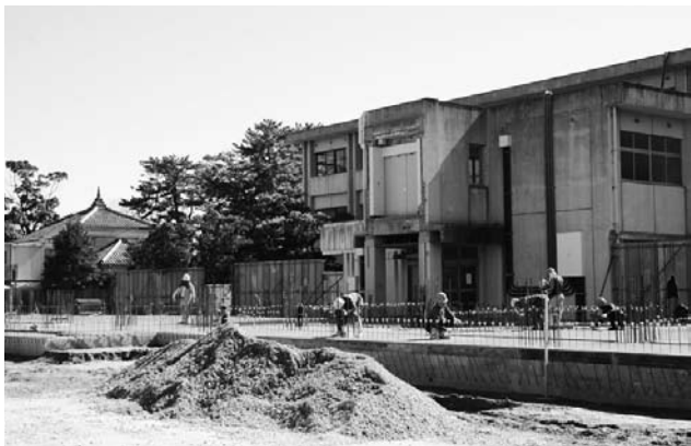
△昨年12月から工事中の萩高本館
