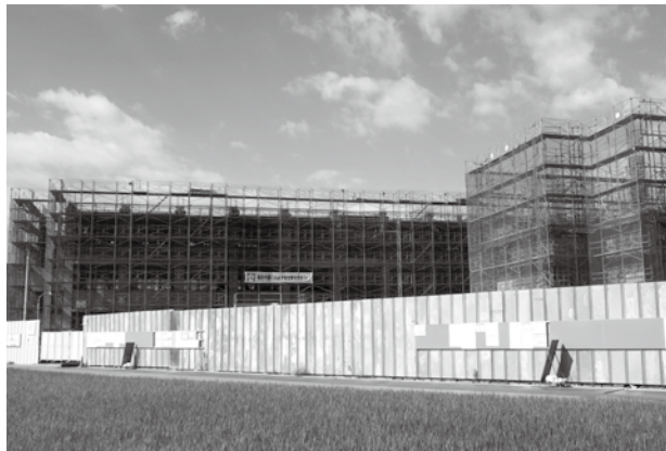
△現校舍裏に建設中の萩商工新校舎(平成20年3月完成予定)
