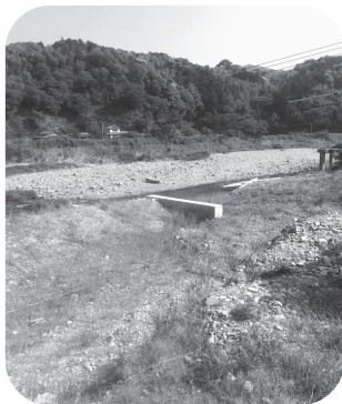
災害により発生した残土
