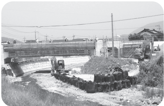
土木作業現場
