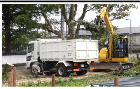
道路の拡幅工事進行中！
