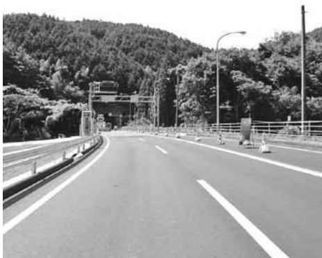
△国道191号須佐トンネル東側付近
