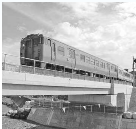
△復旧した鉄橋を走る列車
