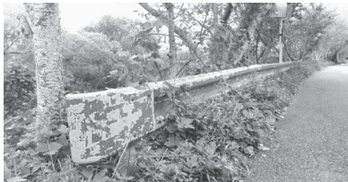
塗装のはがれたガードレール
