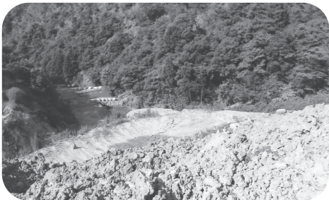
大井残土処理場(下流に相崎部落がある)
