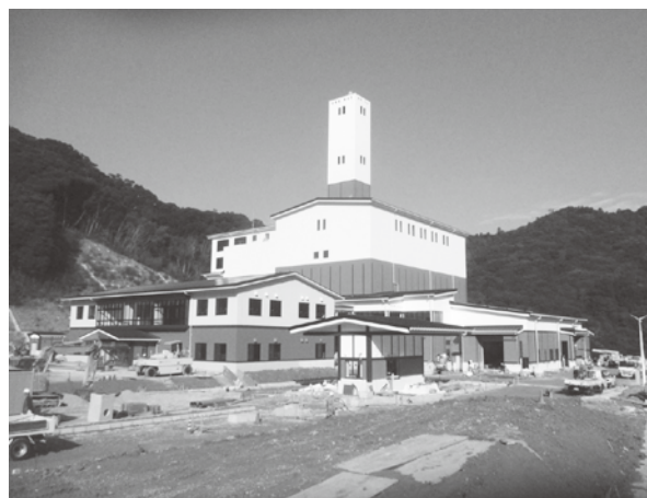
建設中の萩・長門清掃工場（11月20日現在、山田）
