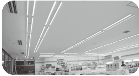
店舗のLED照明
