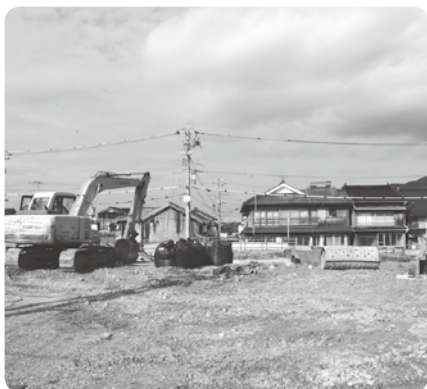
架け替え工事が進む港橋付近(須佐)
