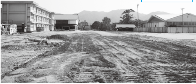
旧萩商業の南側校舎2棟を解体し、跡地に明倫小校舎を新築
