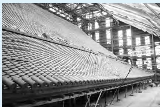
大照院本堂の瓦葺の様子
