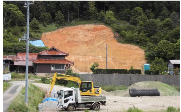
小規模治山工事
