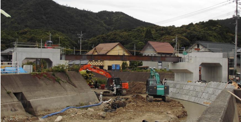
工事中のJR橋(須佐・中津)
