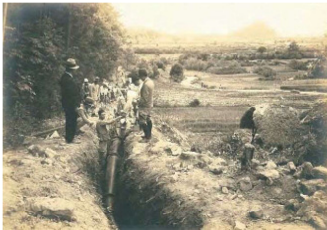
創設当時の送水管布設工事の様子 上野配水池付近
