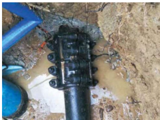
漏水補修完了状況
