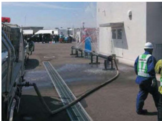
防災訓練の状況（漏水補修訓練）
