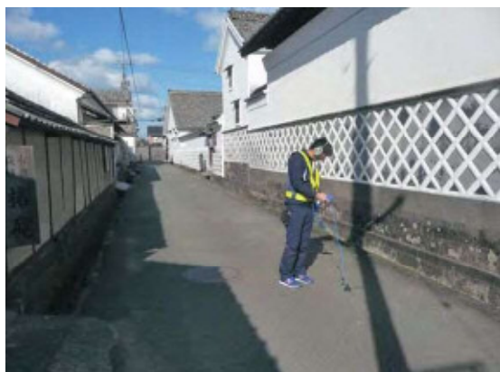
漏水調査の実施状況
