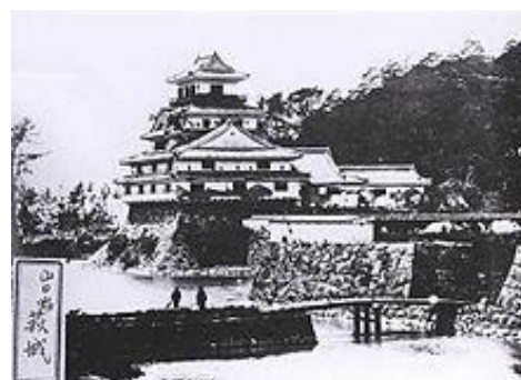
解体前の萩城天守閣を写した古写真
