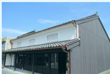
改修後の町家モデル
