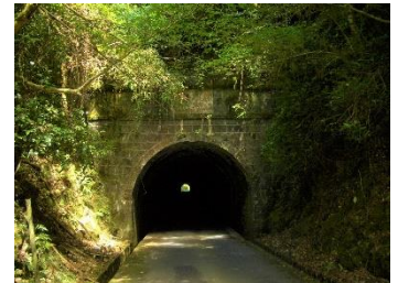
[写真8] 鹿背隧道
