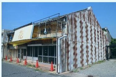
改修前の伝統的建造物
