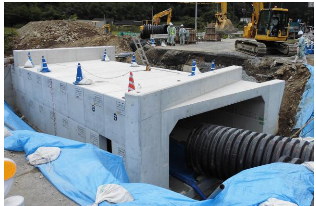
設置された長谷川函渠(ボックスカルバート)
