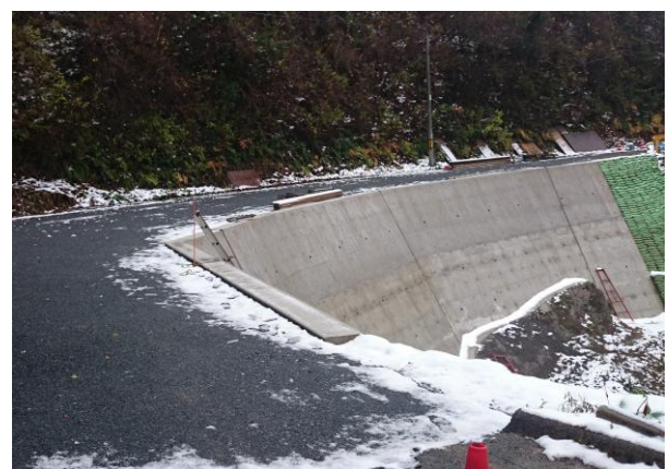
市道及谷線の状況（12月3日）
