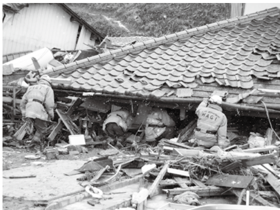
倒壊した家屋内の搜索
