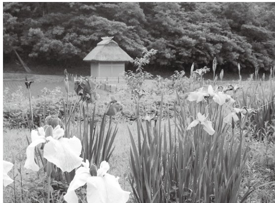
景観に配慮した簡易水道のポンプ所(西木間)
