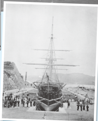
「明治12年(1879)に完成した立神第一ドック」(長崎造船所所蔵)ドックの長さは130mで、当時は東洋最大
