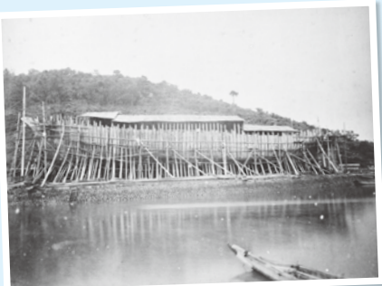
「明治14年(1881)小菅修船場で建造中の小菅丸」(長崎造船所所蔵)船の大きさは1496トンで当時は日本最大
