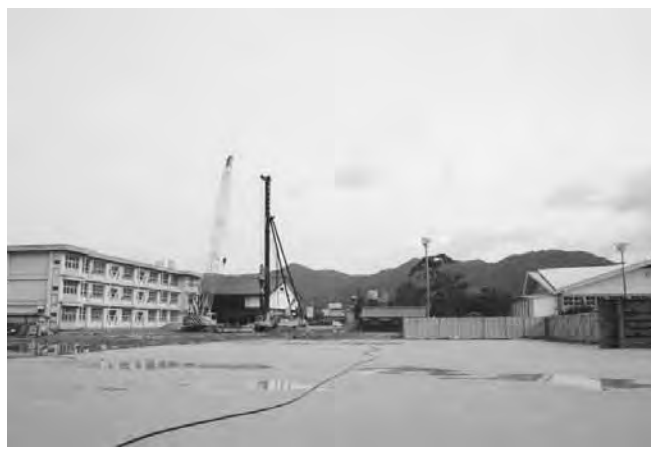
旧萩商業高校校舎を解体し、跡地に明倫小校舎を新築
