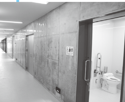
北側通路と多目的トイレ
