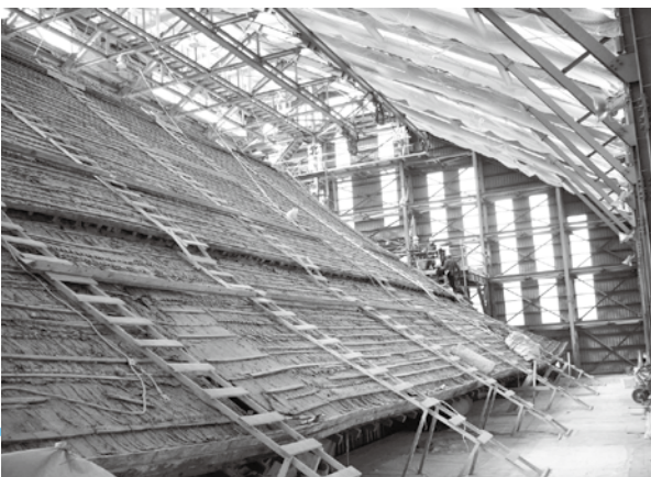
解体中の大照院本堂
