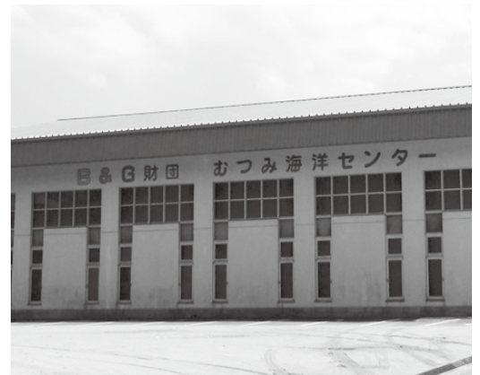
改修が終わったB&G海洋センター体育館
