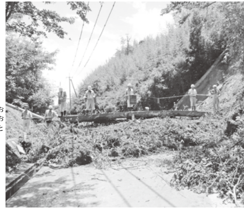
市道大渡吉田線(やすらぎ苑斎場)の土砂崩れ
