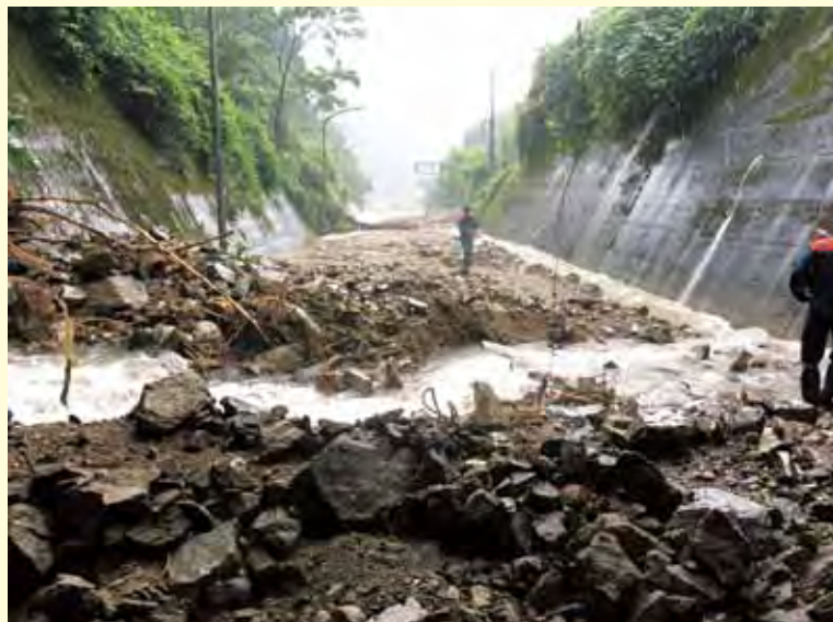
金山谷トンネル (28日)
