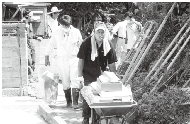
△被災した家屋から荷物を搬出(須佐地区)
