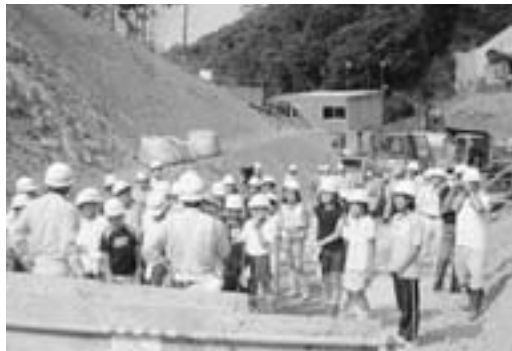
▲萩・三隅道路工事現場見学会
