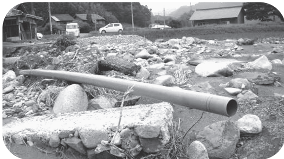
復旧前 道路が寸断され配水管が破損
