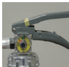
× 安全栓の脱落
