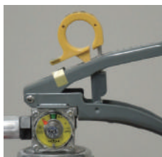
× 安全栓の抜けかけ
