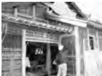
仲間部屋 荒壁塗の様子
