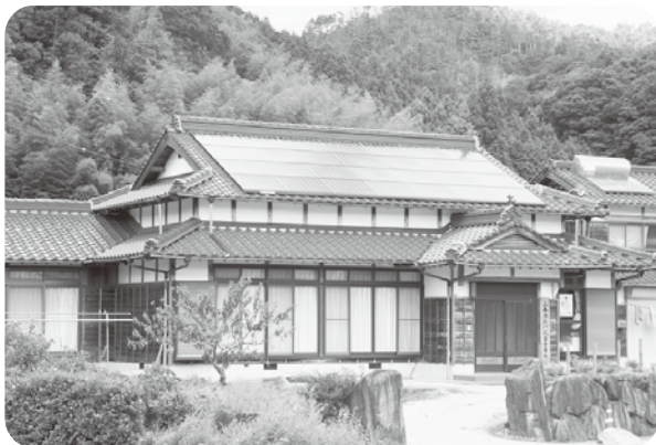
太陽光パネル
