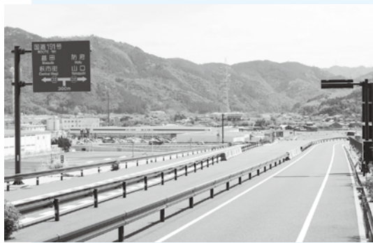
萩インターチェンジ付近(椿地区)
