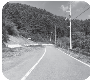
「市道生野高坂線」工事未着手箇所
