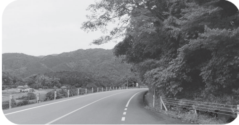
国道262号線の支障木
