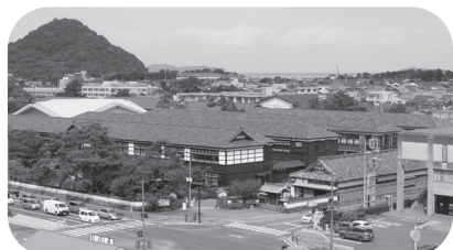
旧明倫小3・4号棟と体育館
