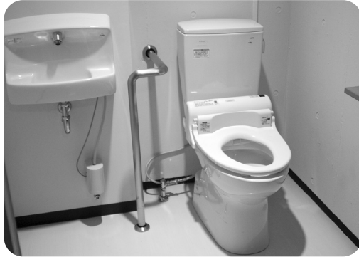
新設された洋式トイレ
