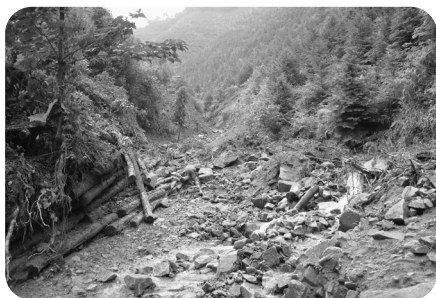
被災した林道
