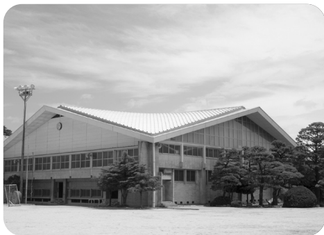
避難所に指定されている明倫小体育館
